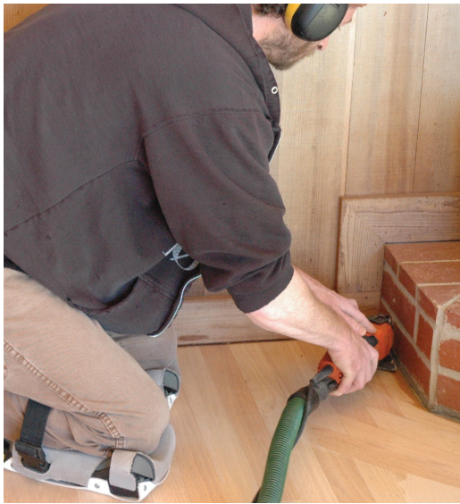
圖片：使用連接至真空過濾系統的磨砂機的工人，以防止木屑進入空氣中。
