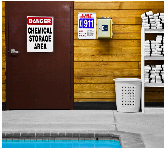
照片：標記清晰的化學物質儲存室。
